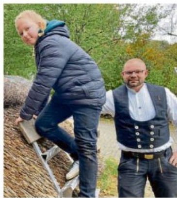
Lukas Rohwedder am Muster-Reetdach. Dachdeckermeister Robert Rogowski schaut zu und erklärt einiges zur Technik.
